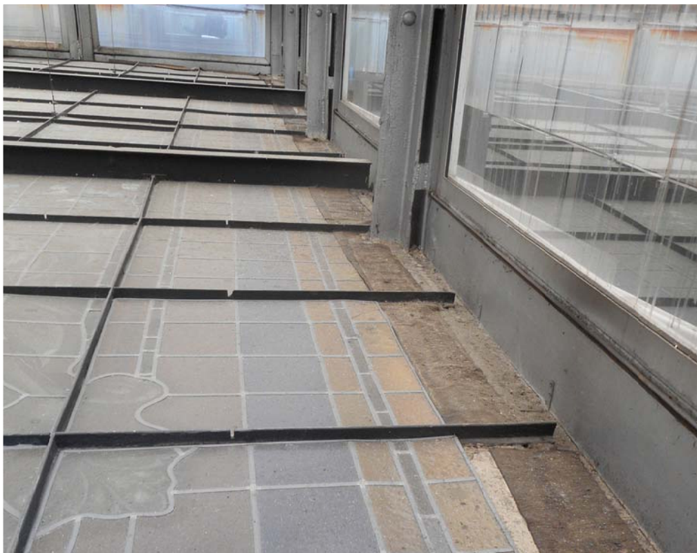
CUADRANTES 3, 6 Y 9, PIEZAS 1L+2L+3L+4L. Deformaciones en placas
