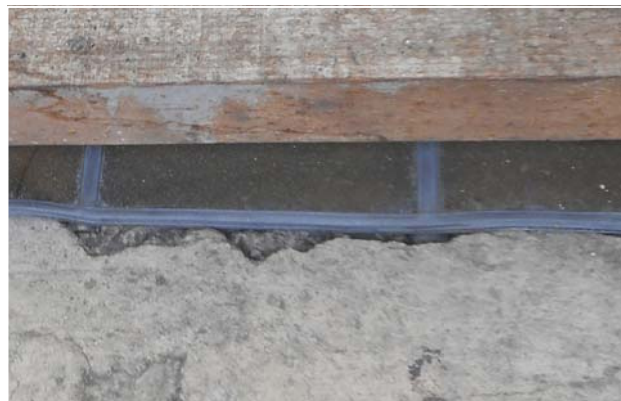
CUADRANTE 3, PIEZA 1K. Deformaciones de las placas en el encuentro con la cornisa
