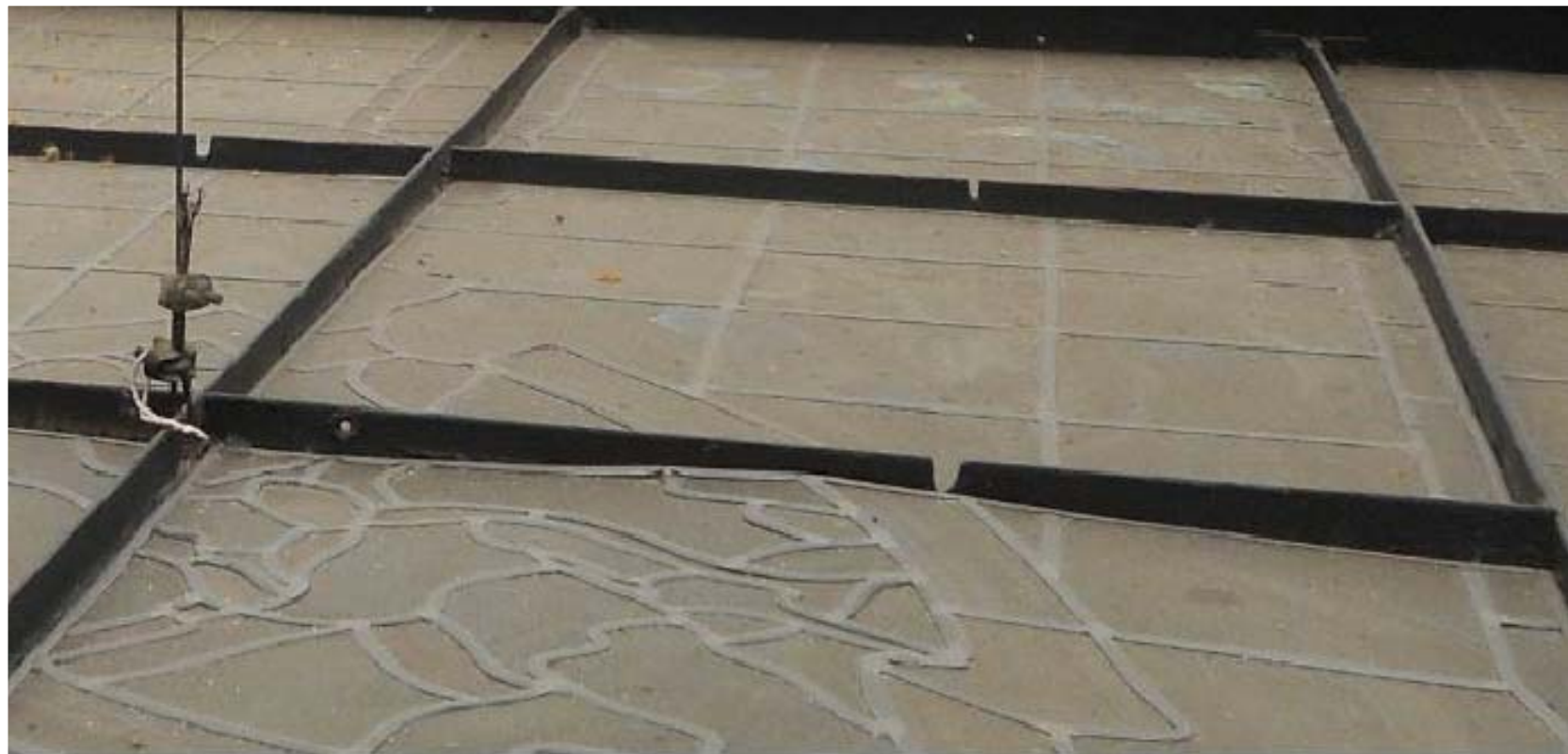
CUADRANTE 3, PIEZA 2K. Placas deformadas en sentido antigravitatorio, probablemente debido a dilataciones asociadas a altas temperaturas
